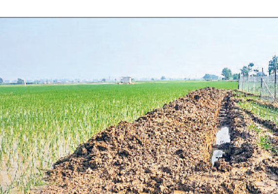
अंबाला। पाइपलाइन के लिए खोदी जा रही खाई।
